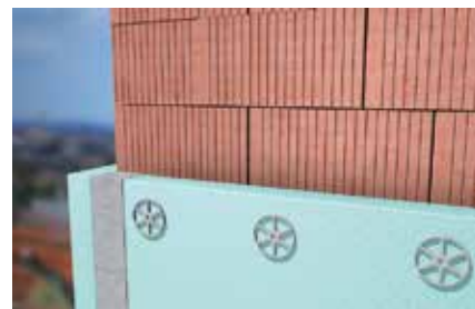
Riempimento di cavità tra pannelli isolanti
